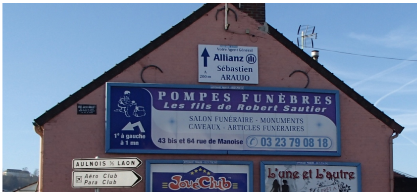
Dépassement de la ligne d'égout du toit – Rue Jacques Gallet
